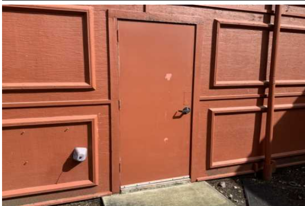
11 EXTERIOR METAL DOOR
